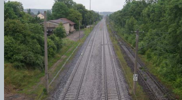
In Leutershausen-Wiedersbach entsteht ein neuer S-Bahn-Halt.
