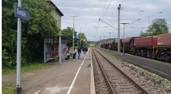
Der Bahnhof Dombühl wird umfassend umgebaut.
