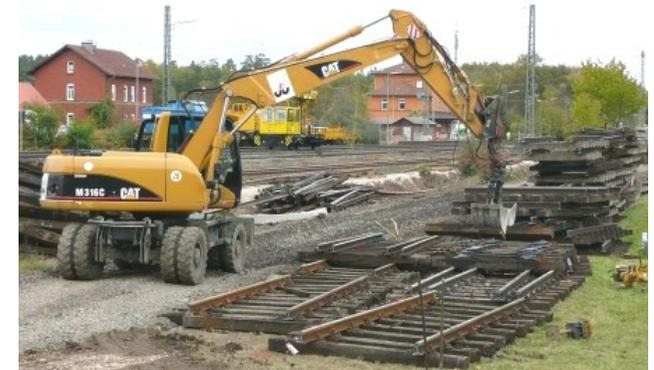
*Am 26.10. stapelt ein Bagger neben der Baustraße Schienenstücke, die im Gleis 5 ausgebaut wurden.*
