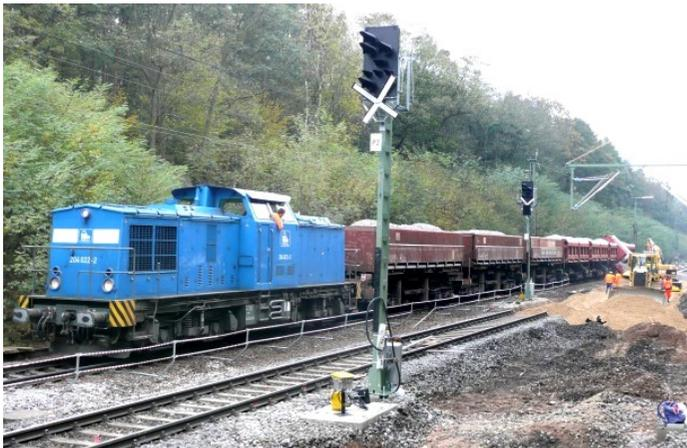
*Am 24.10. schob 204 212 ihren Schotterzug auf dem nördlichen Gleis Richtung Heilsbronn. Rechts ist die Baugrube für die neue Weiche 3 zu erkennen, die gefüllt werden muss.*
