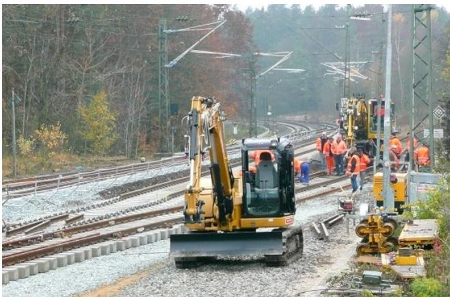
*Der Bagger vorne steht auf der leeren Trasse von Gleis 1. Hinter ihm liegt schon die neue Weiche, über die Züge künftig von Gleis 2 nach Katterbach fahren können.*
